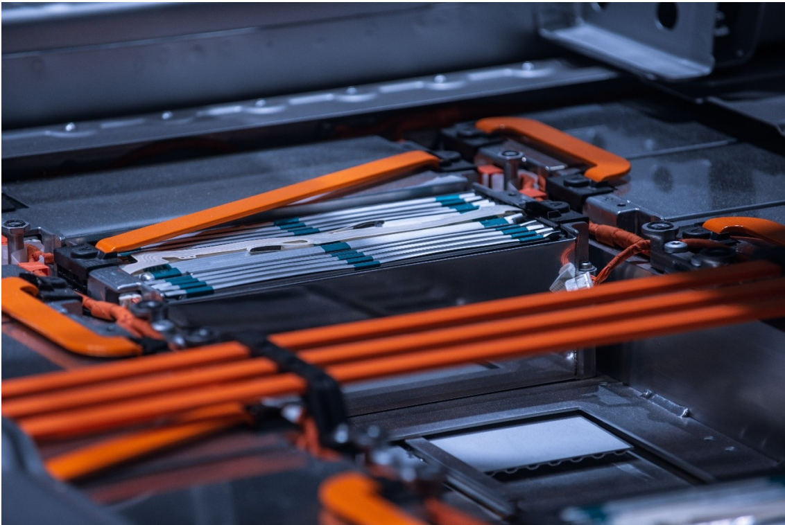
バスバーが走るEV車体
